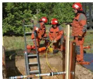
- работа в котловане, траншее
